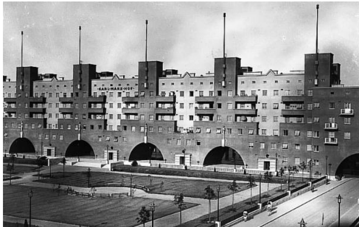
Karl-Marx Hof, Wien 19. (Heiligenstadt) – erbaut zwischen 1926-1930
